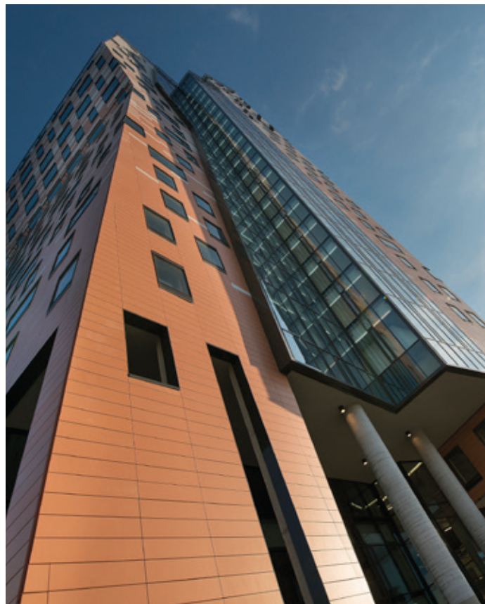
Do portfolia budov, které SCF Servis komplexně spravuje, náleží též AZ TOWER. Foto: PSJ
