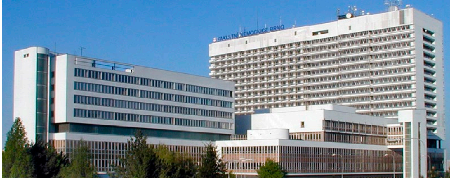
Dceřiná firma SCF Servis realizovala stavební úpravy gynekologicko-porodnického oddělení Fakultní nemocnice v Brně. Foto: PSJ
