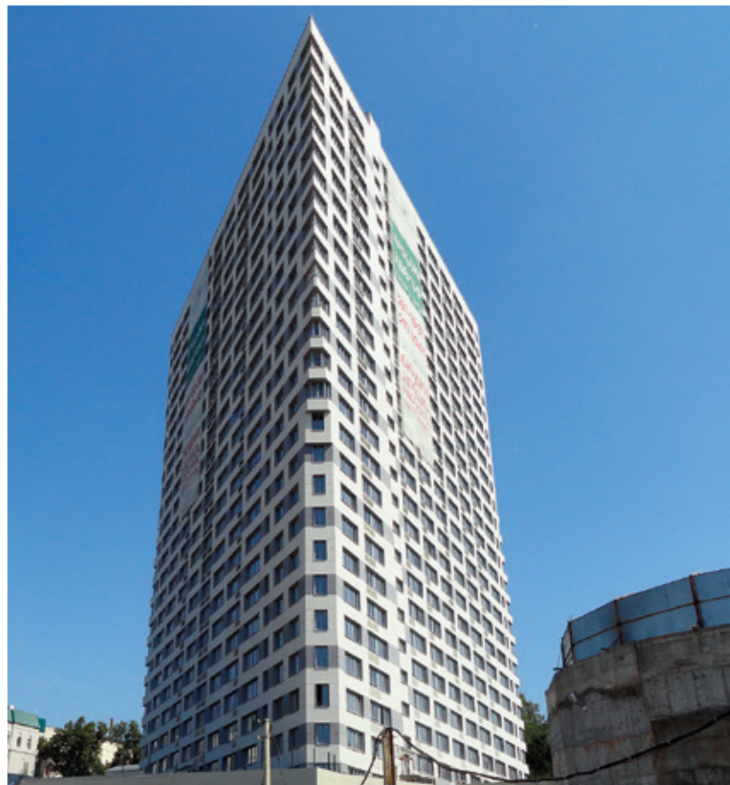
V Kazani vyrostla šestadvacetipodlažní rezidenční budova představující úvodní etapu komplexu Megapolis. Foto: PSJ
