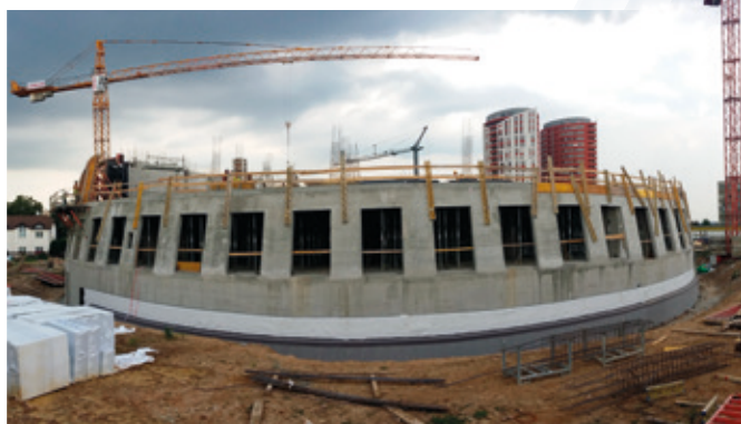
Stavba budoucího Centrálního depozitáře UPM už vyrostla ze země. Foto: PSJ
